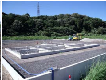
②基礎工事が完了！！
